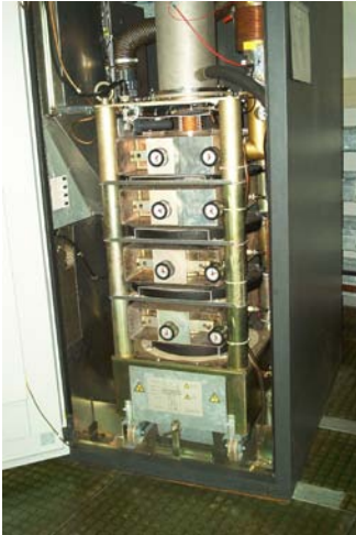
60 kW cw 500 MHz klystron (E2v 2672BCD))
