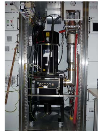
80 kW cw 500 MHz IOT (E2V 2130))
